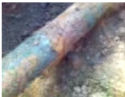
Рисунок 6 – Фото трубопроводу в шурфі № 1 на ПК-09
