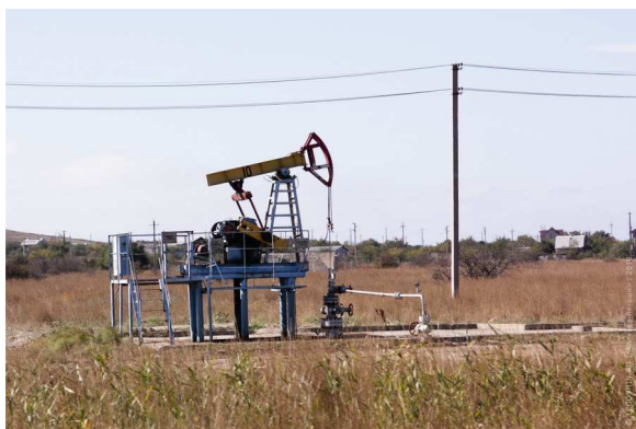
Рисунок 2 – Нефтяная скважина ООО «Азовская Нефтяная Компания»
